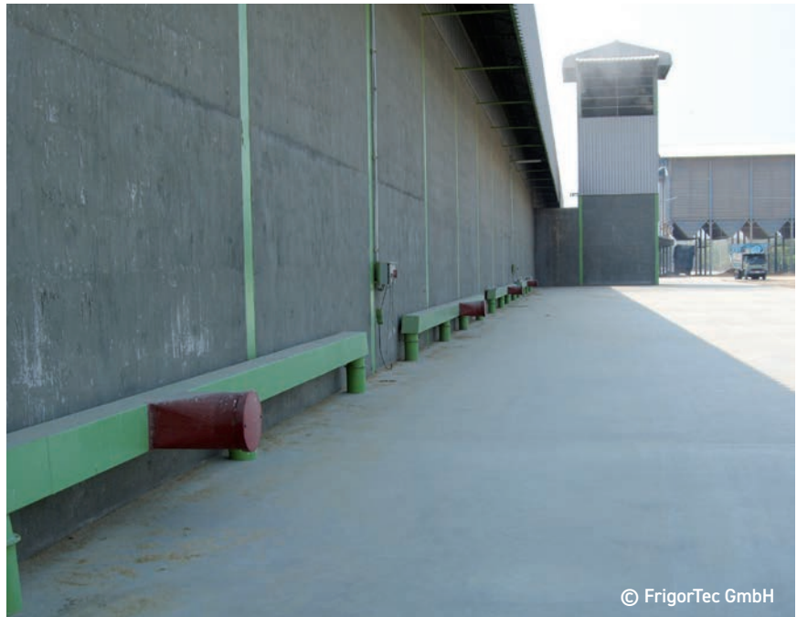
2 Almacén en plano con sistema central de distribución de aire para GRANIFRIGOR™ conservación en frío.
